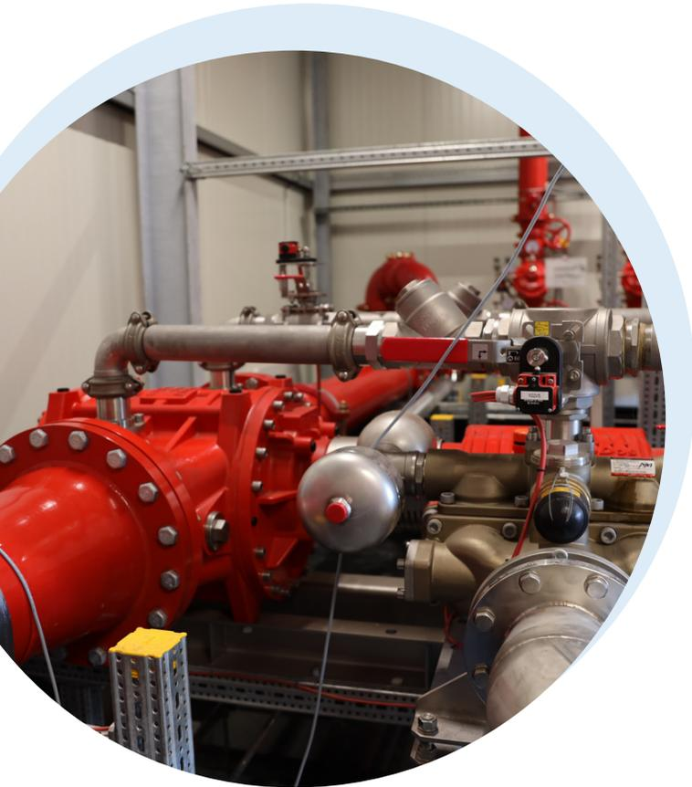
Um die exakte Zumischung von vaPUREx® AR 3/3 F-5 mit 3 % bei allen Volumenströmen zu gewährleisten, setzt der Anlagenerrichter auf eine FireDos Zumischanlage der dritten Generation mit 20.000 L/Min. maximaler Durchflussleistung. Die Saugleitung zum Zumischgerät wurde entsprechend der maximalen Schaummittelbedarfsmenge dimensioniert. Somit wird eine passende Zumischung, der volle Leistungsumfang und die Wirksamkeit des Schaums im Einsatzfall sichergestellt.
